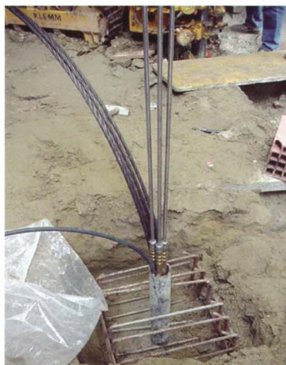
Fig. 9 - Extensómetros aplicados na microestaca
