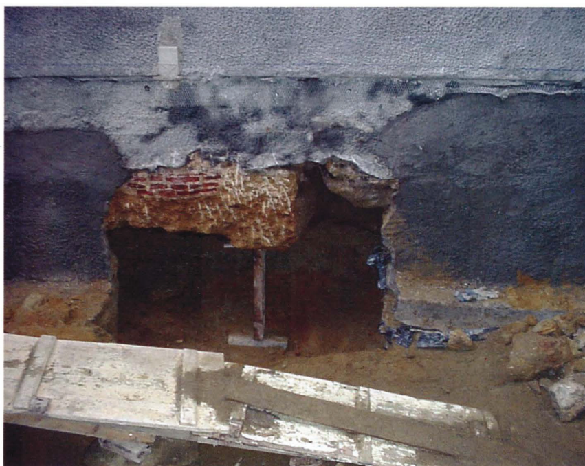
Fig. 1 - Troço de recalçamento da fundação
