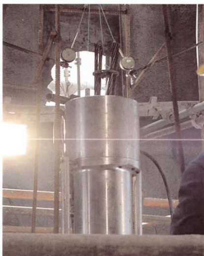
Fig. 8 - Deflectómetros aplicados no macaco
